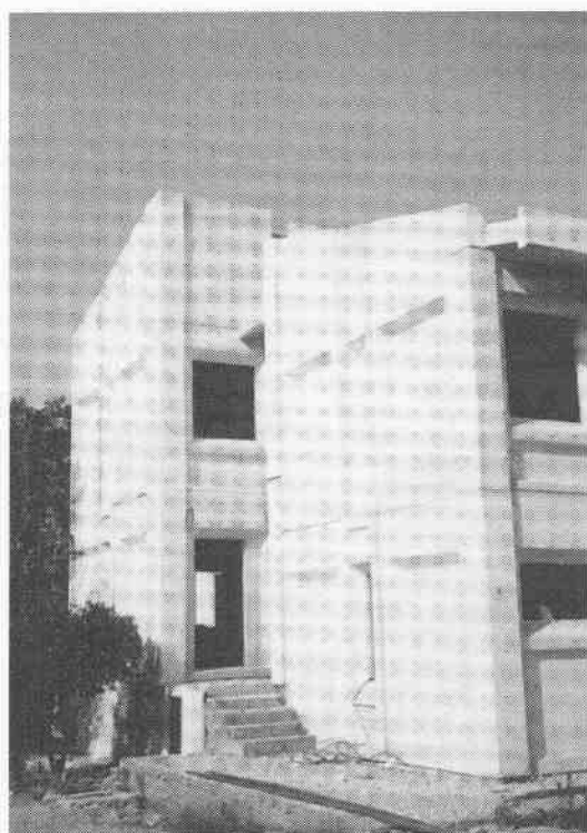
اورودی پشت ساختمان انمای غربی
